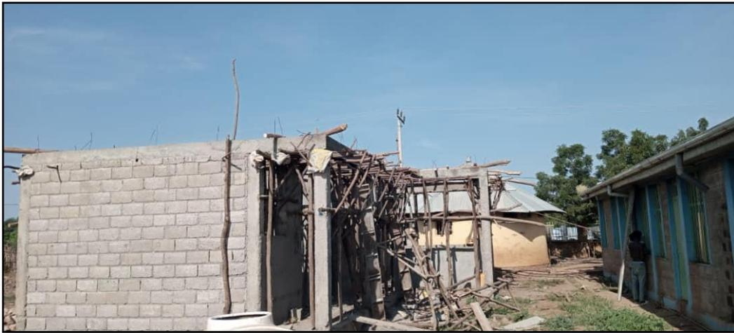
**Décembre 2023**, les fondations et les murs ont pu être posés. La plupart de la structure supérieure est renforcée par des barres de fer. La prochaine étape est de commencer à poser la charpente ainsi que le toit.
