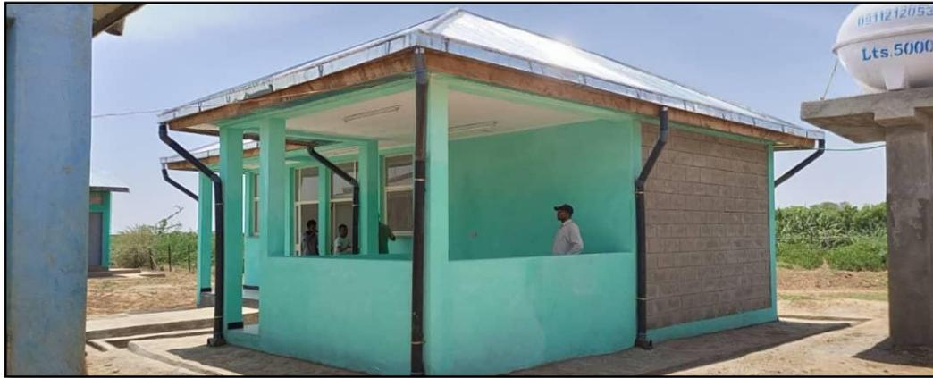
**Mars 2024**, le projet est terminé. Le réservoir de 5'000 litres a pu être posé sur sa structure en béton armé. Des rigoles ont été installées tout autour de la toiture afin d'évacuer l'eau de manière optimale. Le bâtiment a aussi été peint avec sa couleur finale, propre à tous les bâtiments du centre médical.
